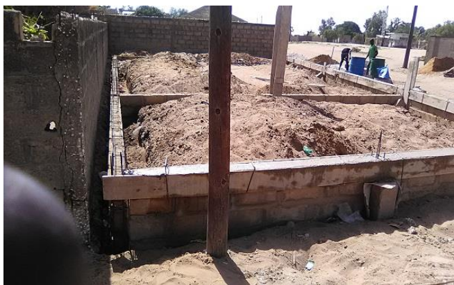
Das Fundament wurde gemauert und betoniert
