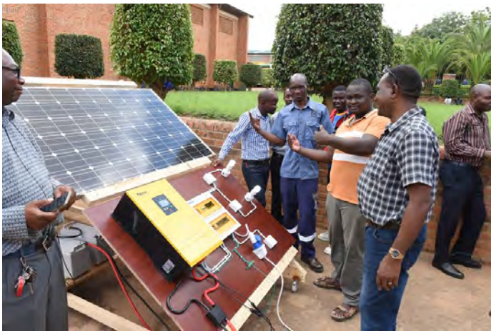
Inbetriebnahme der Photovoltaik-Hybrid-Anlage durch die Teilnehmer
